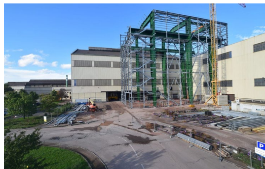
Chantier des travaux de la Coulée Continue Verticale Le Creusot – Septembre 2024
