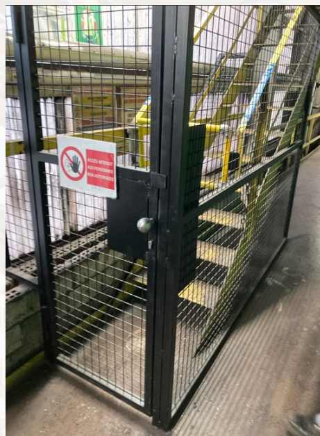
Accès aux chemins de roulement de pont roulant sur le site d'Industeel Charleroi.
