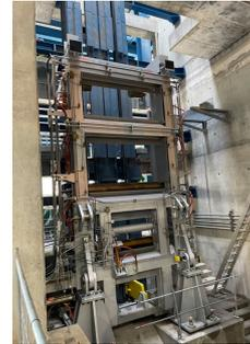
*Chantier des travaux de la Coulée Continue Verticale Montage des premiers équipements de la machine Le Creusot – Avril 2025*
